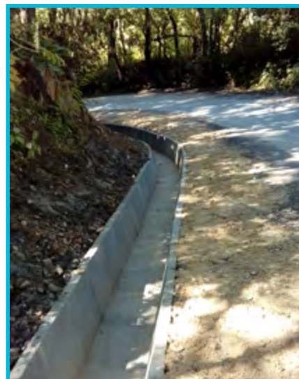
Remont odwodnienia drogi gminnej Soślina – Naszacowice
