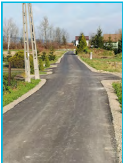
Remont drogi gminnej „Polna” – Stadła
