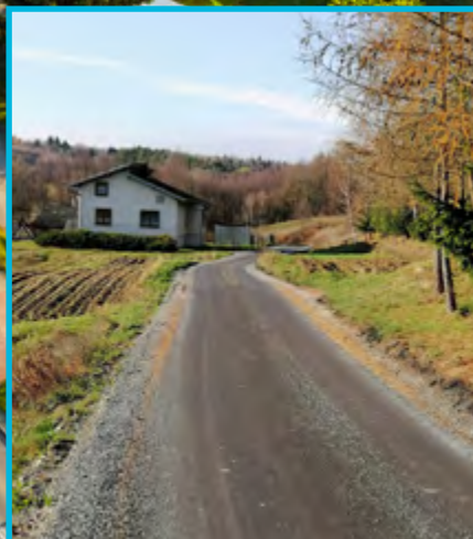
Remont drogi gminnej „Koło Krocza” – Podegrodzie
