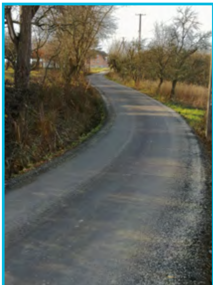
Remont drogi gminnej „Krawcówka” – Juraszowa
