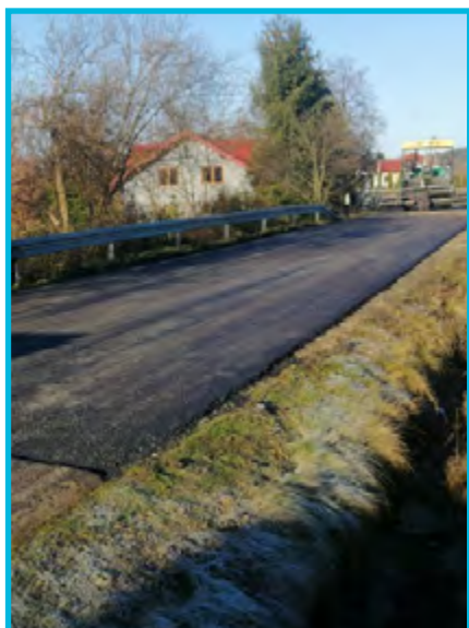
Remont drogi gminnej Osowie – Rogi – Podegrodzie
