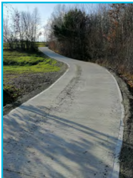
Remont drogi gminnej „Łąki Mrozówki” – Gostwica
