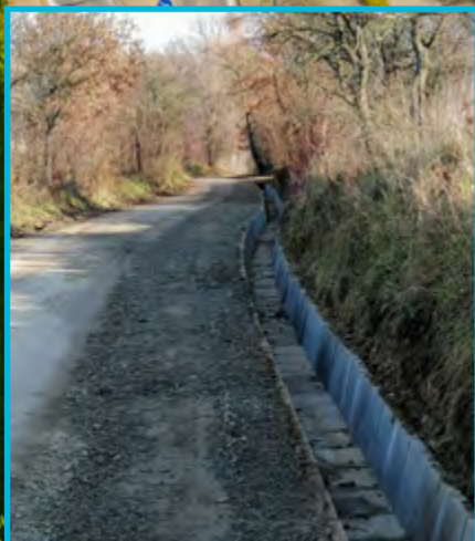
Remont drogi gminnej (odwodnienie) na „Sokowinę” – Mokra Wieś
