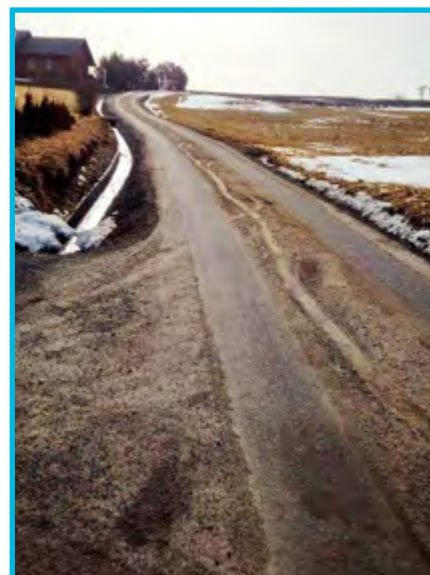
Remont drogi gminnej „Łazki II” (Pod Salamona) – Długotłęka-Świerkla
