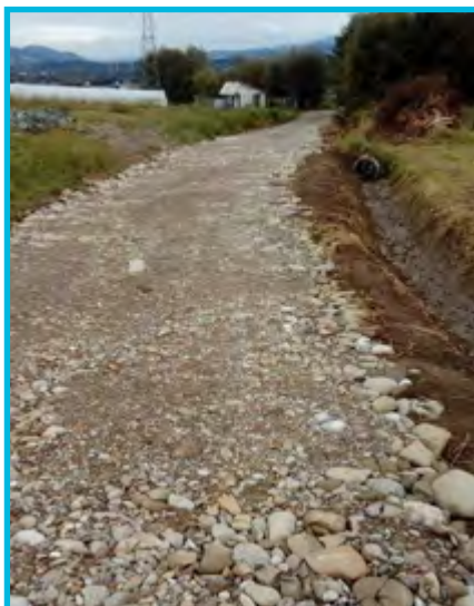
Utwardzenie drogi gminnej w kierunku tzw. Klina – Chochorowice
