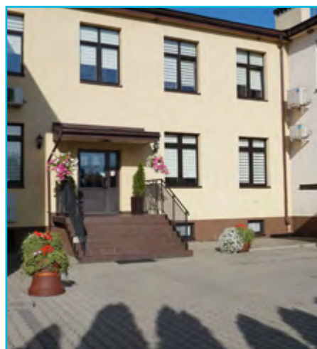
Podegrodzie – zabezpieczenie antywłamaniowe w budynku Urzędu Gminy.
