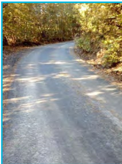
Remont drogi gminnej „Łaski” (Osieki) – Podegrodzie
