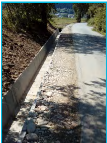
Wykonanie odwodnienia drogi gminnej (ułożenie korytek) – Naszacowice
