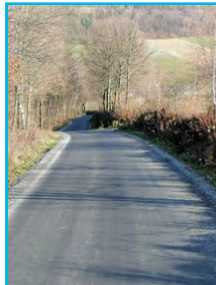
Remont drogi gminnej „Rębacz” (Kolbuszówka) – Długoteka-Świerkla
