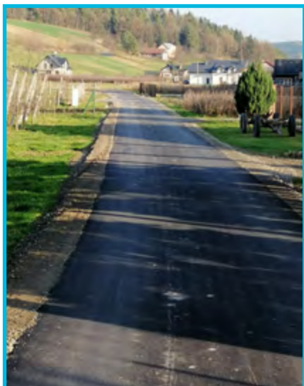
Remont drogi gminnej „Równia” – Olszanka
