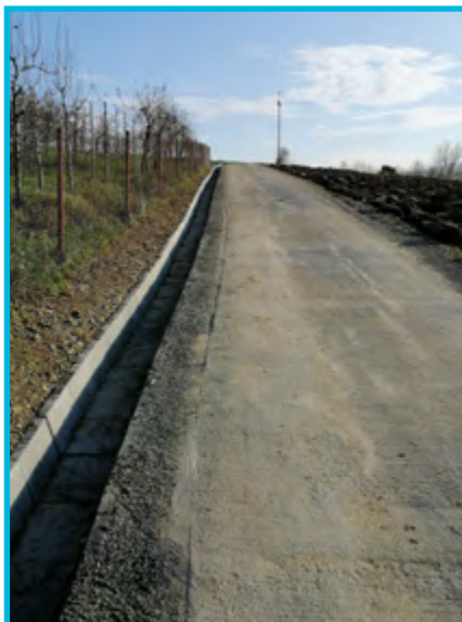
Remont drogi gminnej „Działy” – Rogi
