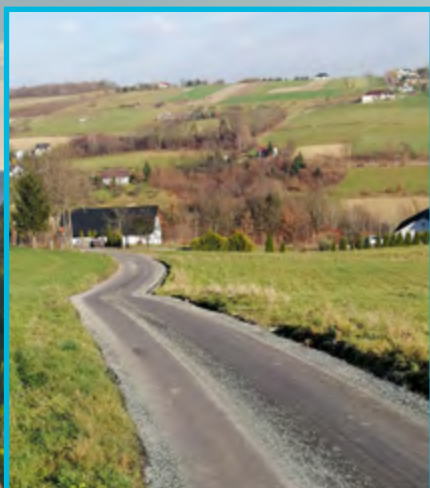
Remont drogi gminnej „Do Golonki” – Brzezna
