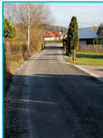
Remont drogi gminnej „Osiedleniowa” – Olszanka
