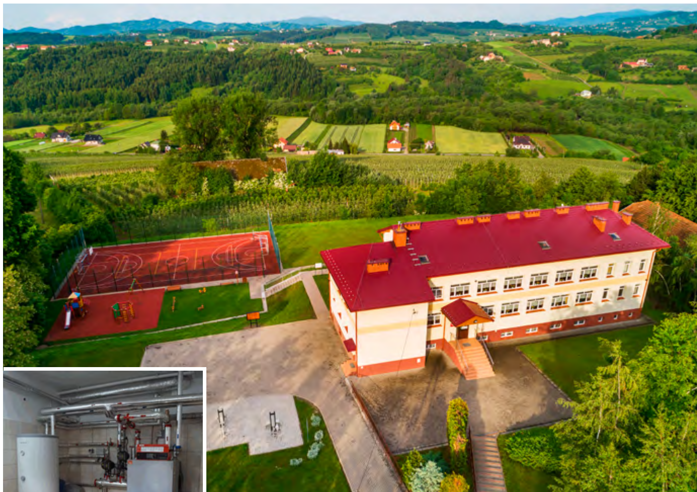
Remont kotłowni w Szkole Podstawowej w Rogach – w pomieszczeniu kotłowni został wymieniony stary piec węglowy na nowoczesny piec na olej opałowy dostosowany w przyszłości do wymiany palnika na gazowy. Wartość zadania 163 436,25 zł.
