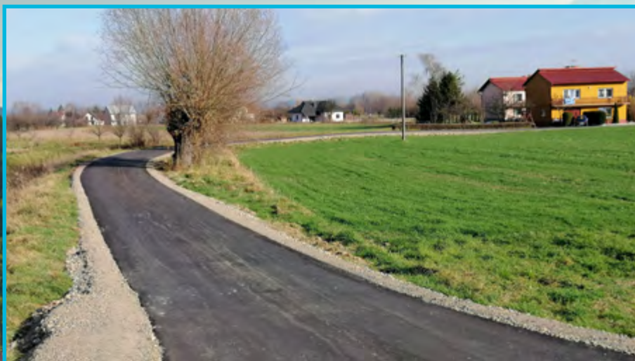
Remont drogi gminnej „Do Olszaka” – Stadła
