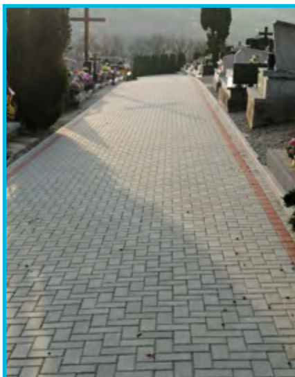
Wykonanie chodnika w głównej alejce na starej części cmentarza w Brzeznej
