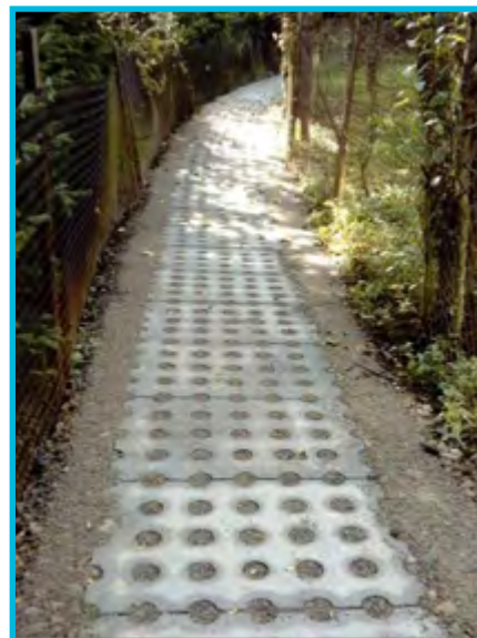
Remont ścieżki pieszej koło P. Porębskiej – Podegrodzie
