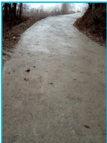
Remont drogi gminnej „Za Rzeką” – Długolęka-Świerkla
