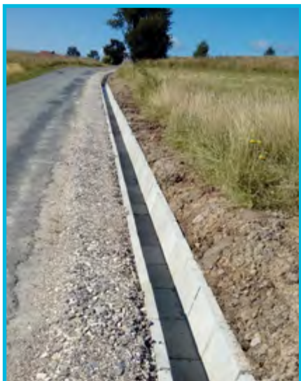
Ułożenie korytek (czyszczenie rowu) przy drodze gminnej na – Mokra Wieś
