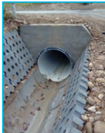
Remont drogi gminnej Janczurówka (odwodnienie) – Olszana
