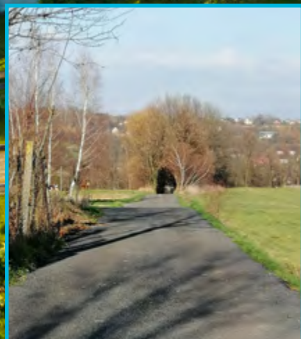
Remont drogi gminnej „na Łyskowicę” – Gostwica
